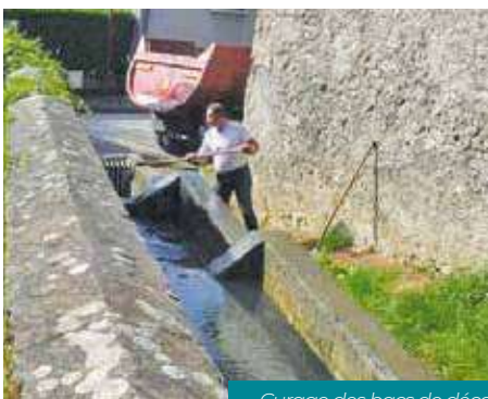
Curage des bacs de décantation du ruisseau Charvan
