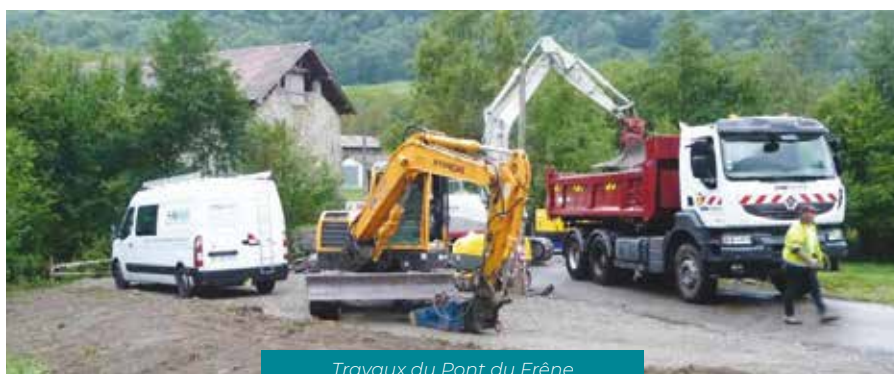
Travaux du Pont du Frêne
