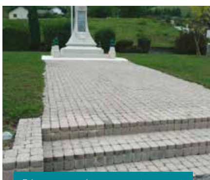
Décapage pavés monument aux morts
