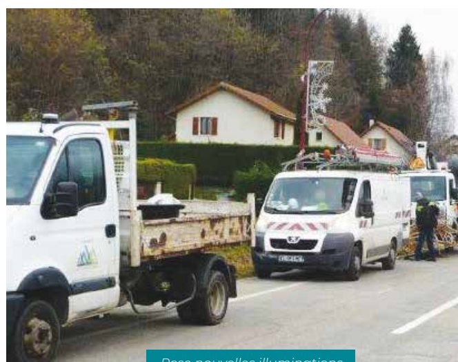
Pose nouvelles illuminations
