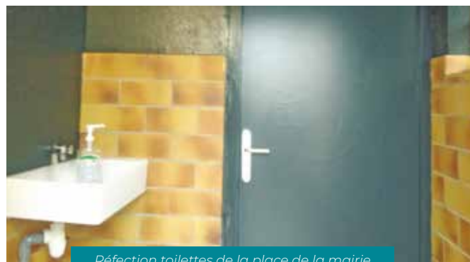
Réfection toilettes de la place de la mairie
