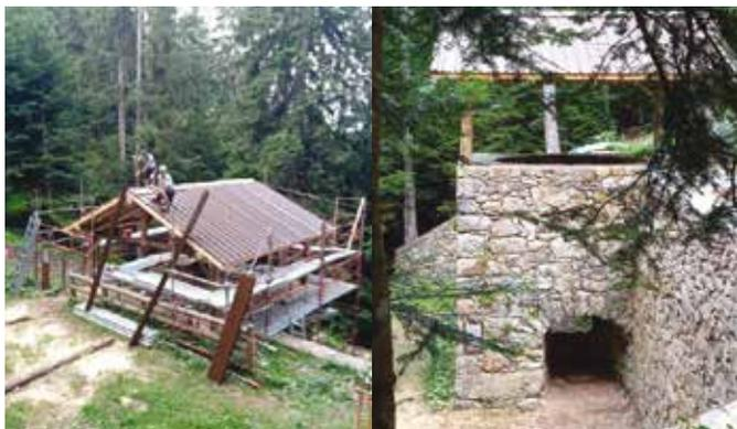
Débuté en 2021 par l'abattage des arbres nécessaires, un an de séchage, le débardage, en juin 2022 les sapins sont prêts au façonnage ! Profitant de l'échafaudage prêté par l'entreprise José Alexandre permettant un travail en toute sécurité, notre équipe, en 10 jours a construit le toit.
