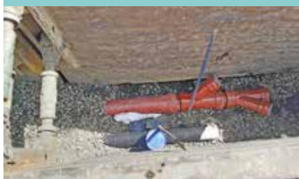
Nouvelles conduites d'eau usées (avec raccordements) et d'eau potable
