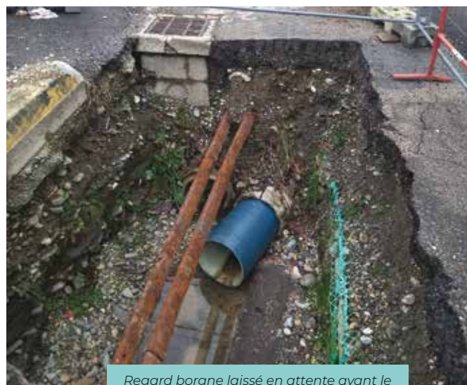
Regard borgne laissé en attente avant le chemisage du réseau d'eaux pluviales
