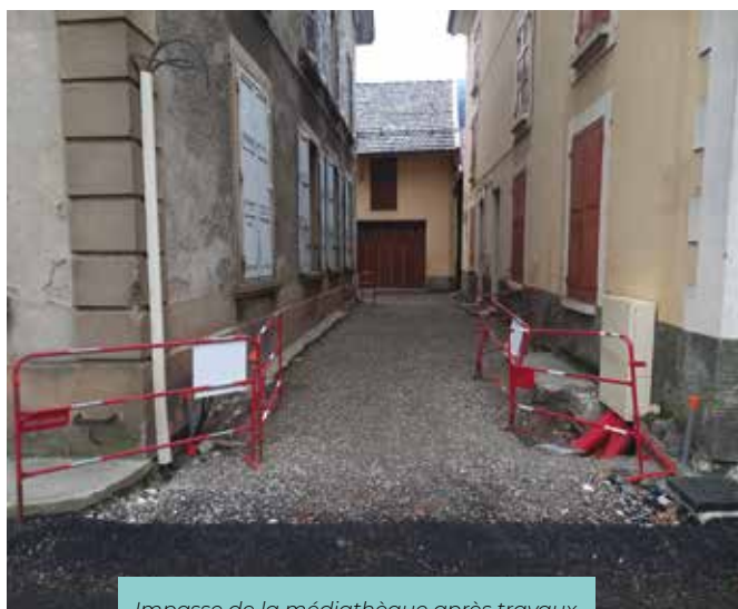
Impasse de la médiathèque après travaux
